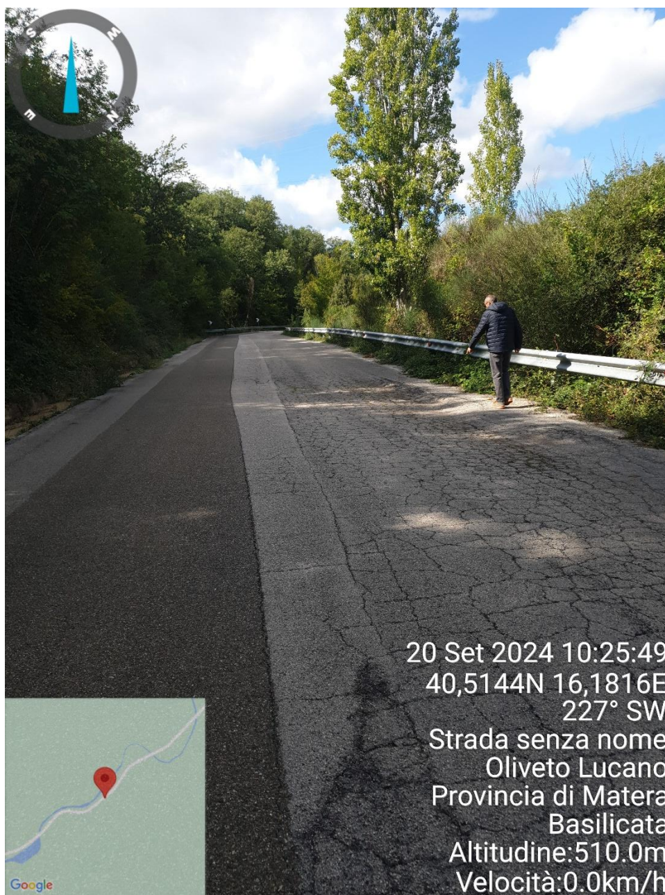
Foto 2 – Stato di fatto della pavimentazione stradale al km 2+500
