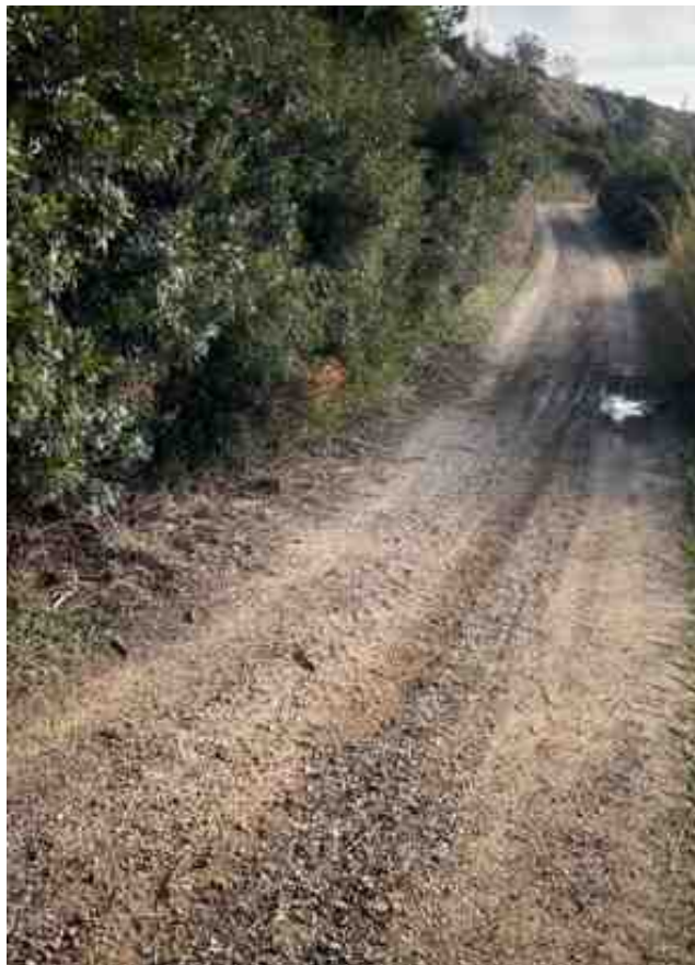
TRATTURO: INTERVENTI CON MISTO STABILIZZATO
