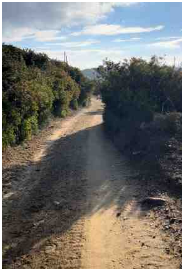
TRATTURO: INTERVENTI CON MISTO STABILIZZATO
