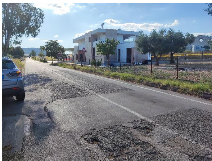
Figura 1: nei cerchi, alcuni delle problematiche descritte in precedenza: 1) strato di base esposto; 2) Strati superficiali disgregati; 3) ormaie e fessurazioni longitudinali; 4) carreggiata invasa da fango.
