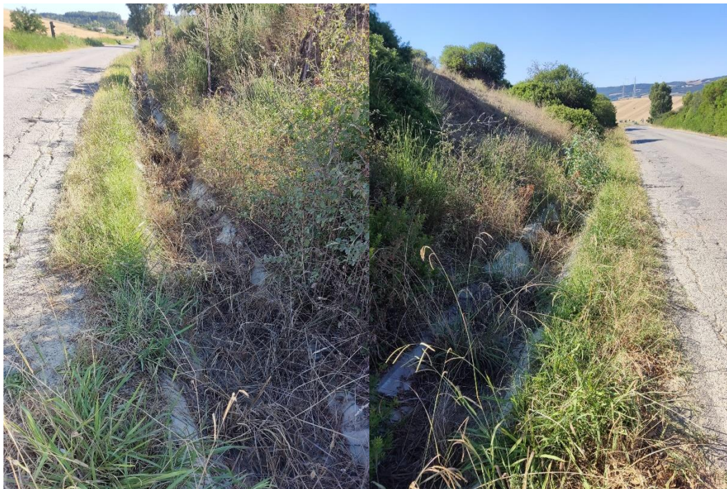
Figura 8: cunetta quasi completamente occlusa
