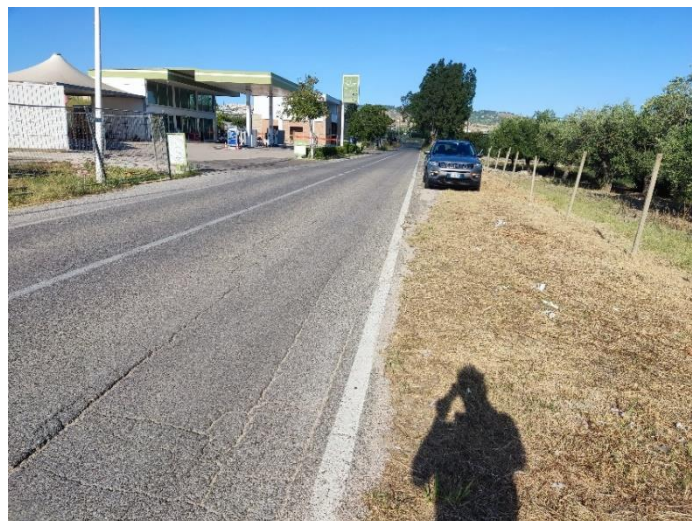
Figura 1: nei cerchi, alcuni delle problematiche descritte in precedenza: 1) strato di base esposto; 2) Strati superficiali disgregati; 3) ormaie e fessurazioni longitudinali; 4) carreggiata invasa da fango.
