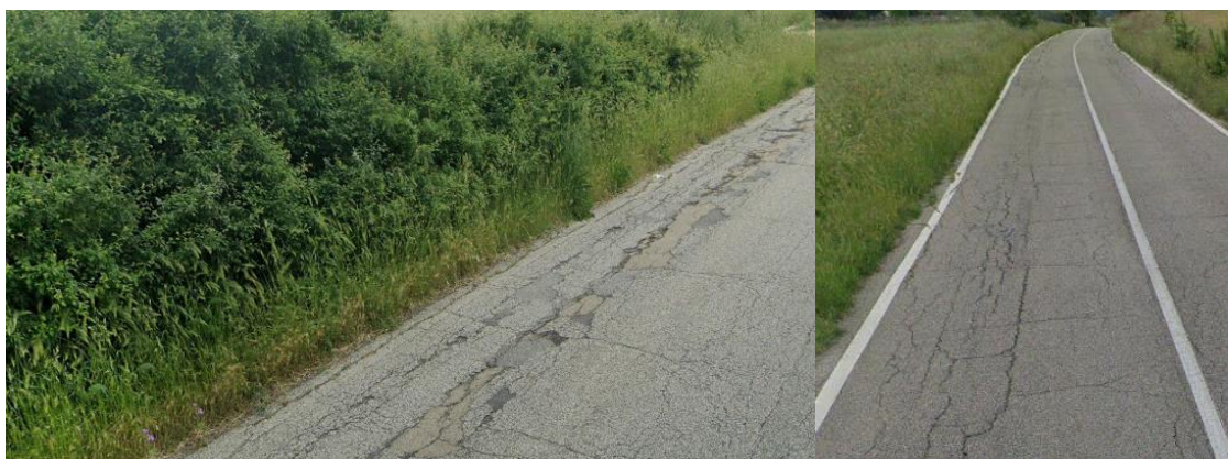
Figura 4: problematiche pacchetto stradale, cedimenti laterali e ormaie
