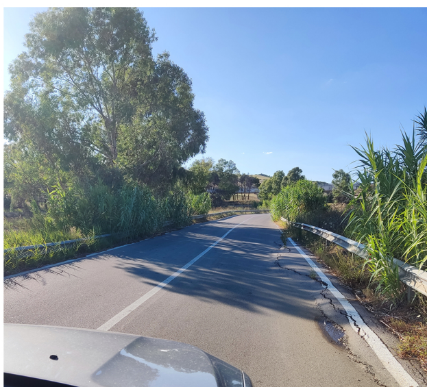
da sx a dx, dall'alto in basso: g) h) i) l) m) particolari ponte privo di barriera di sicurezza; n) o): cedimenti stradali e cunette inerbite
