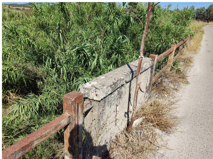
a sx a dx, dall'alto in basso: t) u) v) ponte sulla SP 83 privo di barriere di sicurezza su entrambi i lati
