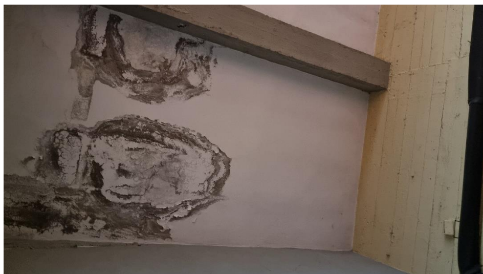
Quadro fissurativo del solaio sovrastante l'accesso in palestra (situazione peggiore ed in corrispondenza del ballatoio sovrastante)
