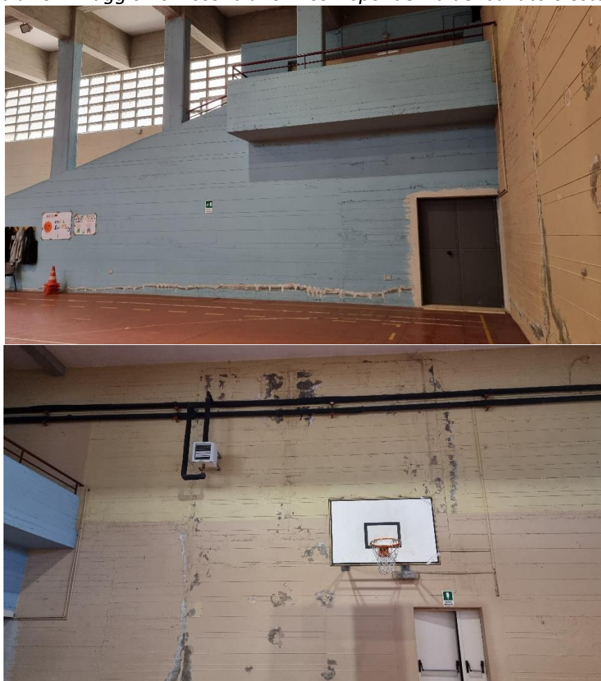
Quadro fissurativo del solaio sovrastante l'accesso in palestra dalle scale (anche in questo caso le infiltrazioni maggiori si riscontrano in corrispondenza del ballatoio esterno)
