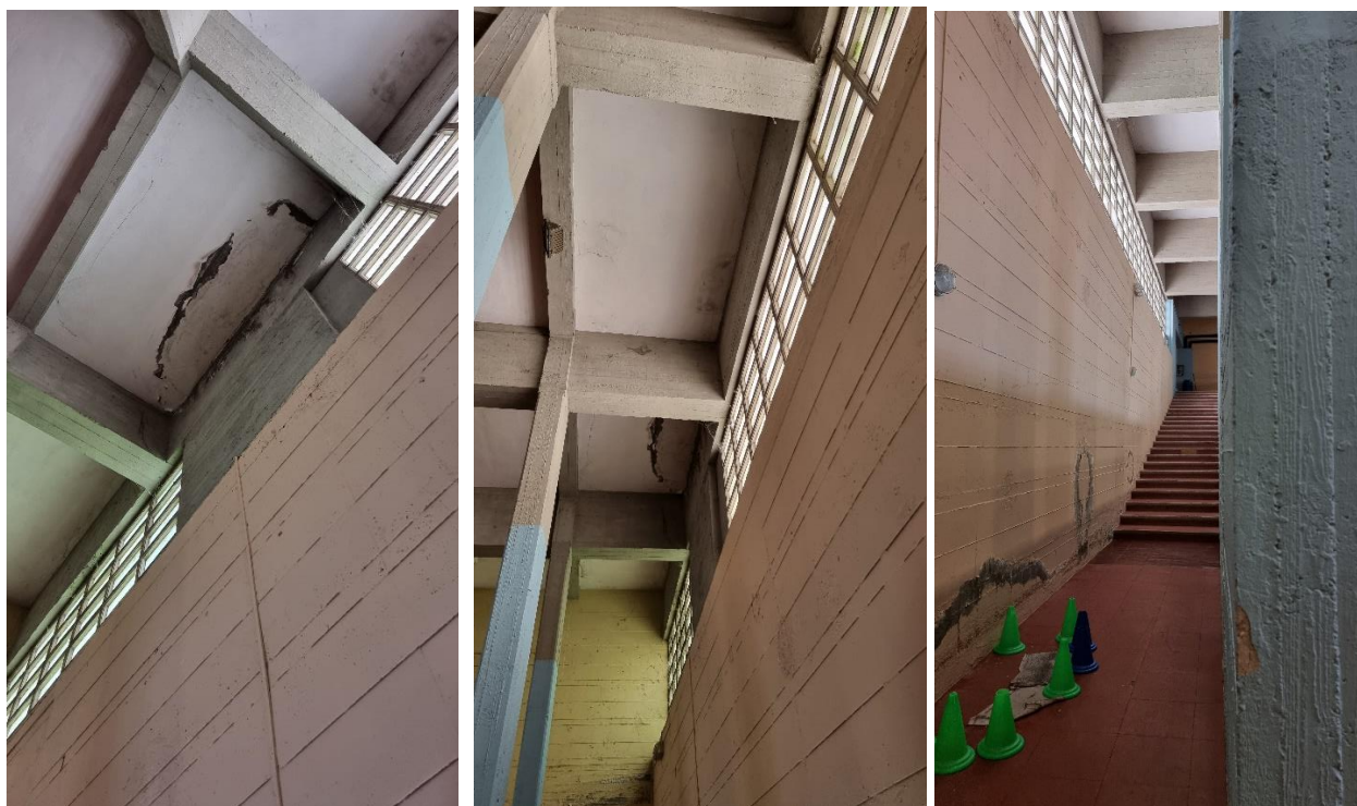
Quadro fissurativo del solaio sovrastante l'accesso in palestra dalle scale (anche in questo caso le infiltrazioni maggiori si riscontrano in corrispondenza del ballatoio esterno)
