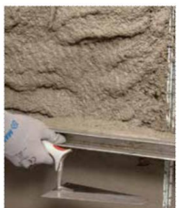
FS - V e VI Secondo strato di malta fibrorinforzata, staggiatura, ripianatura e strato di finitura
