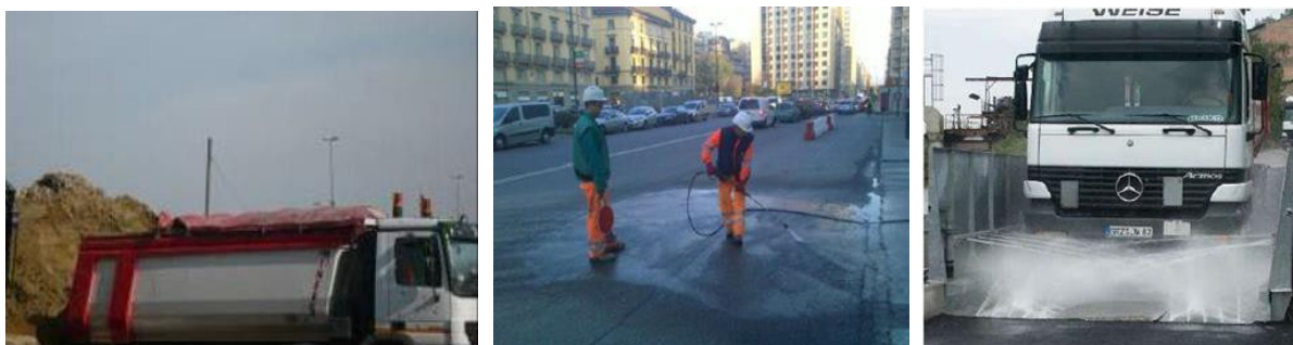
fig. 02: esempi di misure di mitigazione delle polveri (da sinistra: telo avvolgibile sui cassoni dei mezzi, pulizia delle strade, sistema per lavaggio delle ruote dei mezzi)
