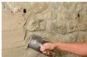
FS - I e II Realizzazione dei fori per connettori e I mano di Malta Fibrorinforzata
