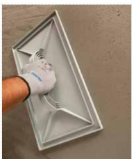
FS - V e VI Secondo strato di malta fibrorinforzata, staggiatura, ripianatura e strato di finitura
