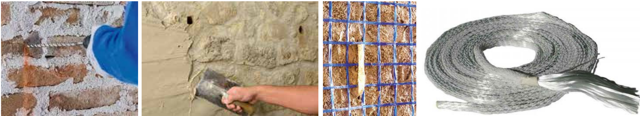
FS - I e II Realizzazione dei fori per connettori e I mano di Malta Fibrorinforzata
