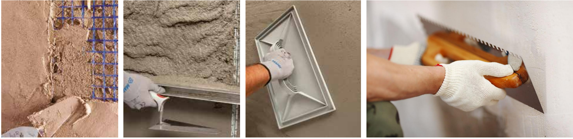
FS - V e VI Secondo strato di malta fibrinforzata, staggiatura, ripianatura e strato di finitura
