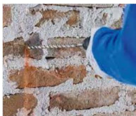
FS - I e II Realizzazione dei fori per connettori e I mano di Malta Fibrorinforzata
