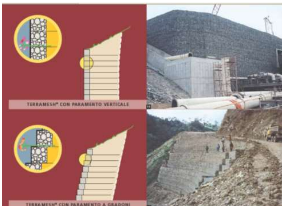
Montaggio terre armate tipo "system"
