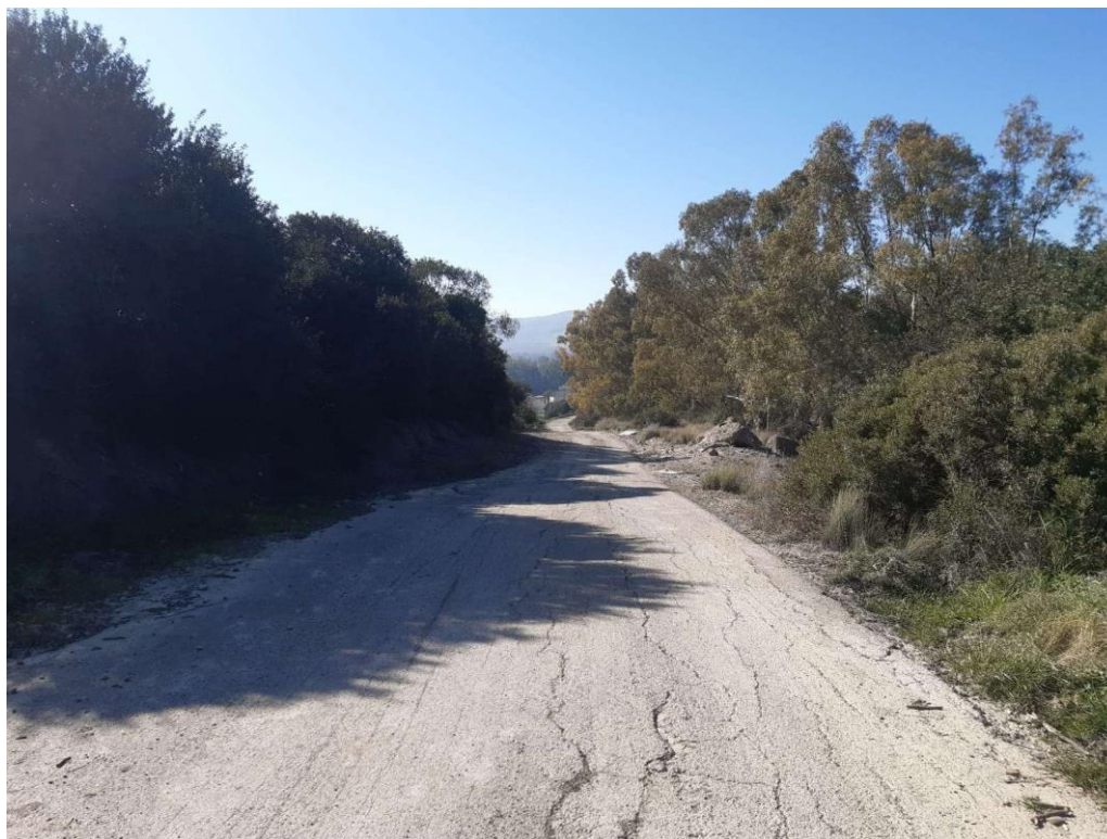
Figura 6 – Stato della pavimentazione stradale
