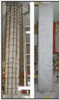
Realizzazione di una incamiciatura in c.a.
