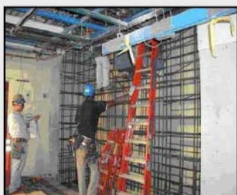
Realizzazione di una parete di taglio in c.a.
