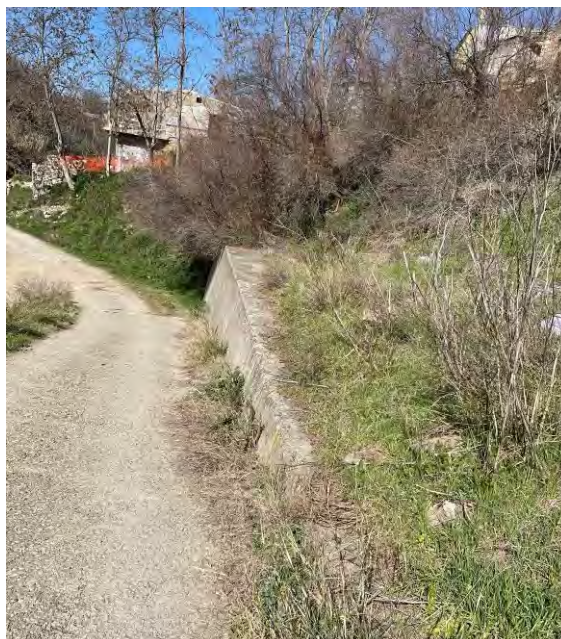
Foto 8 Opera di sostegno in Fosso Camardi (muro in c.a. esistente)
