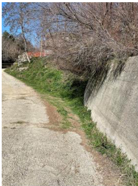
Foto 7 Opera di sostegno in Fosso Camardi (muro in c.a. esistente)
