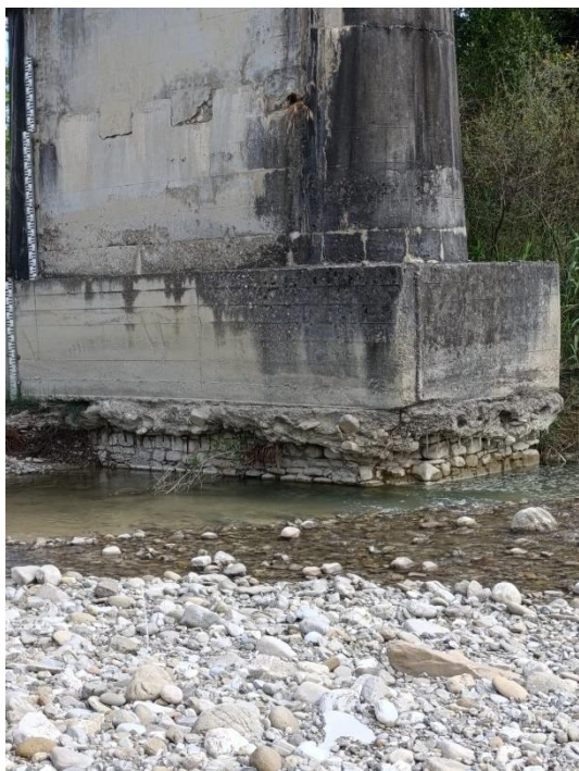
Foto 7 – Stato di fatto delle base delle pile del ponte Sauro
