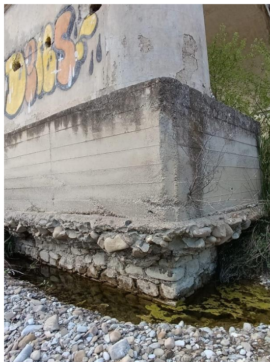
Foto 7 – Stato di fatto delle base delle pile del ponte Sauro
