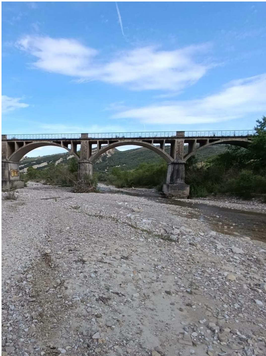
Foto 8 – Pile del ponte Sauro interessate da fenomeni erosivi
