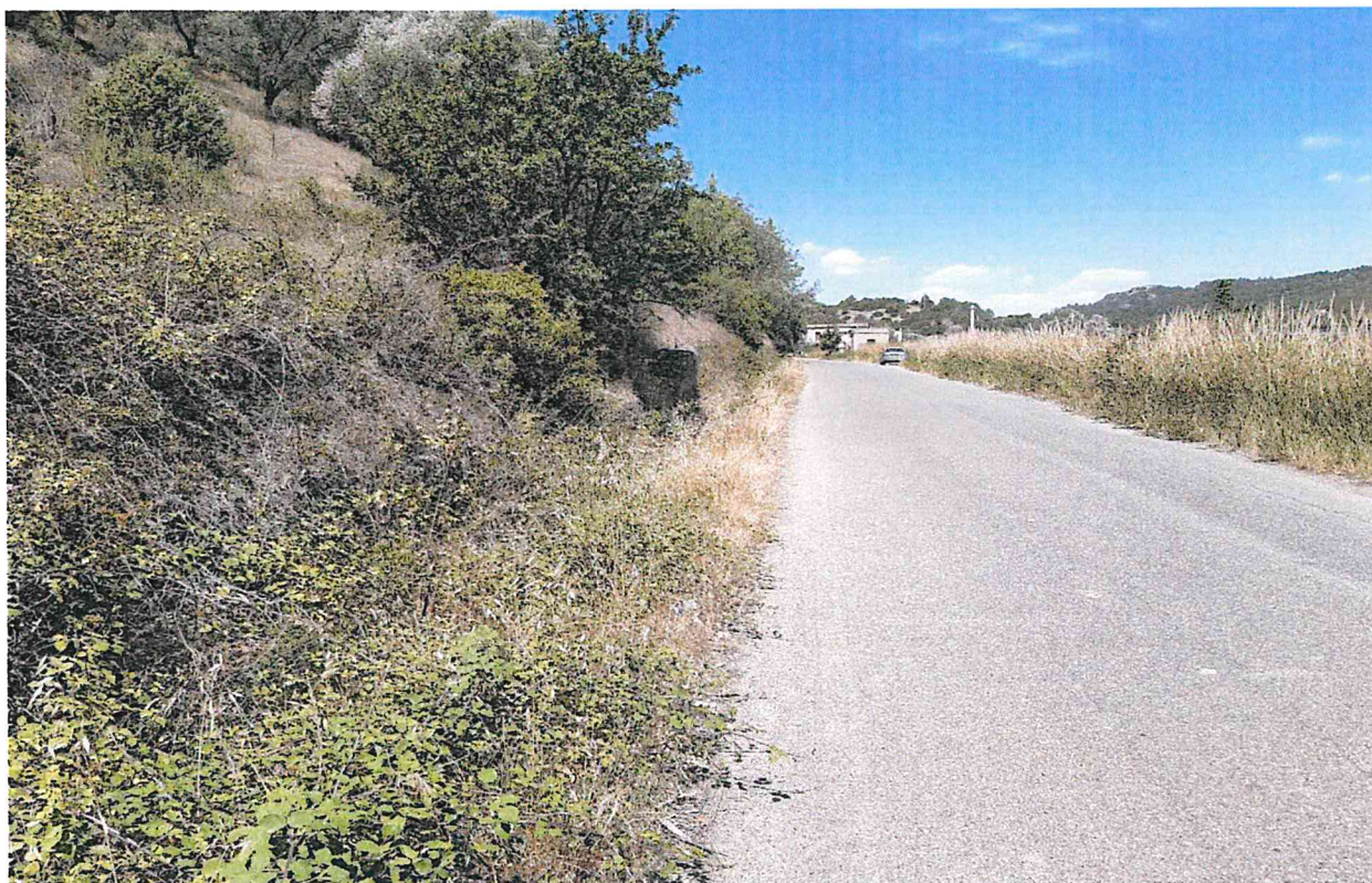
Figura 3 – Cunette perimetrali occluse
