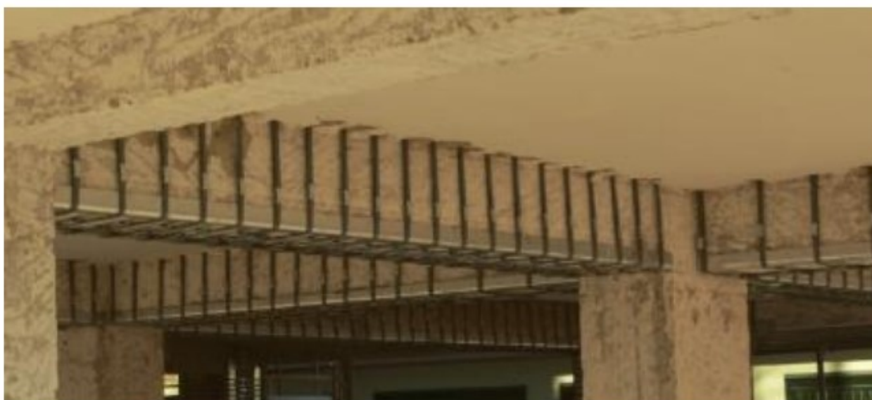
Fig. 4. Esempi di rinforzo travi in c.a. con tecnica CAM
