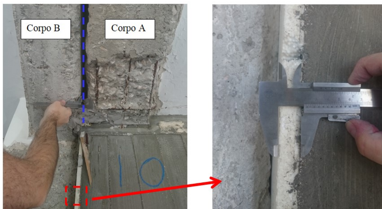
Fig. 8. Rilievo del giunto tecnico esistente fra il Corpo A e il Corpo B in corrispondenza della pilastrata 10 (v. elaborati grafici in allegato)
