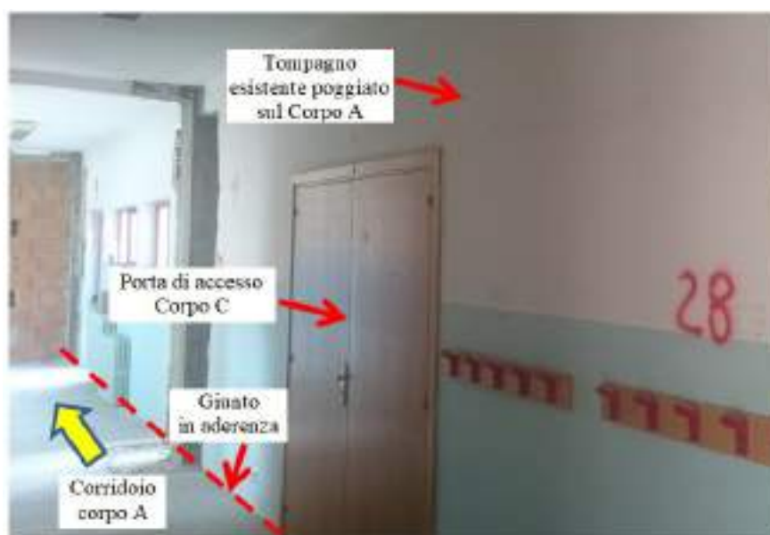
Fig. 11. Individuazione del giunto di separazione fra Corpo A e Corpo C in corrispondenza del corridoio centrale
