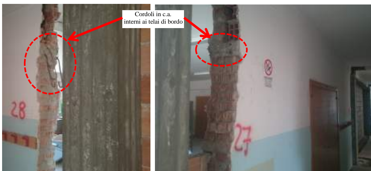
Fig. 17. Rilievo di cordoli in c.a. interni ai telai di bordo fra il Corpo A ed il Corpo C
