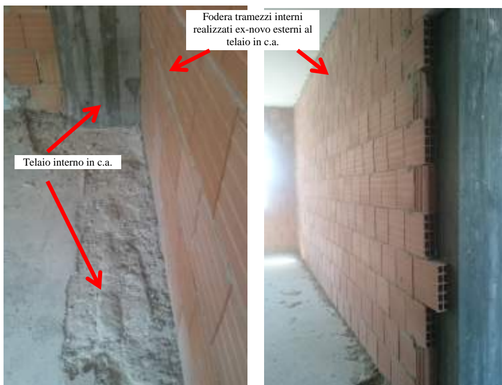
Fig. 16. Rilievo delle tramezzature interne (sp. 10 cm) realizzate ex-novo all'esterno dei telai in c.a.
